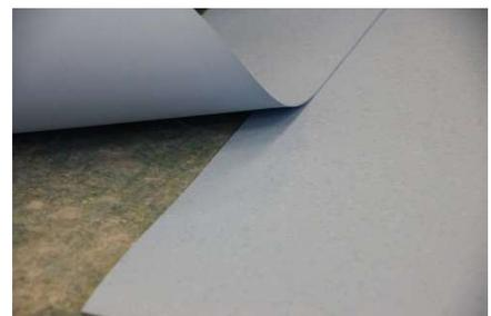
Mit Linealführung (ca. 1 cm Abstand zur geschnittenen Bahnenkante) wird mit dem nora<sup>®</sup> Kantenschneider die werkseitig beschnittene Kante begradigt und gleichzeitig die darunterliegende Bahn angeschnitten (angeritzt). Alternativ zum nora<sup>®</sup> Kantenschneider kann auch der Railcut (Fa. Wolff) verwendet werden, **nicht** jedoch der Linocut.
