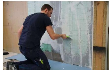
Beim Einlegen der Bahnen muss eine vollflächige Benetzung der Belagsrückseite erreicht werden. Die Belagskanten ohne Spannung einlegen, auf keinen Fall pressen oder stauchen. Da anschließend verfugt werden muss, darf die Fugenbreite 0,3 mm nicht überschreiten.
