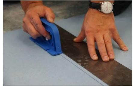
Es hat sich in der Praxis bewährt, den unteren angeritzten Belagsstreifen mit der Hakenklinge abzutrennen. Das Schneiden mit Unterkantenschnitt nach dem Einlegen des Belags ist nicht zu empfehlen, da die Gefahr der Naht-
