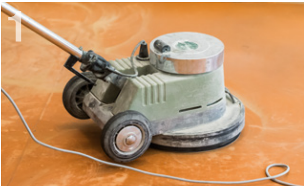
Untergrund abschleifen, absaugen und nora® nTx 020 Haftvermittler auftragen; erneut abschleifen und absaugen.
