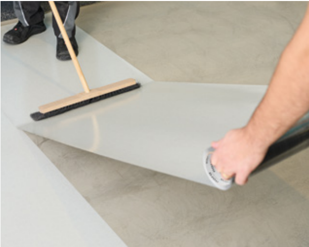
nora dryfix™ 750 auf Fläche verlegen, Schutzpapier abziehen.
