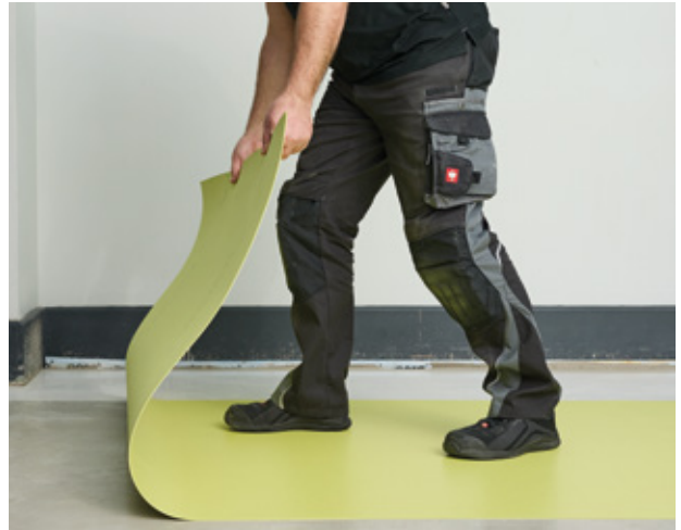
nora® Bodenbelag verlegen, mit nora® Fugenmasse oder nora® Thermoschnur verfugen.
