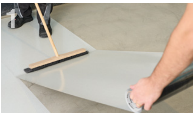
nora dryfix™ ed auf Fläche verlegen, Schutzpapier abziehen.
