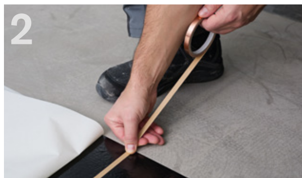
Selbstklebendes Kupferband auf nora dryfix™ ed applizieren.
