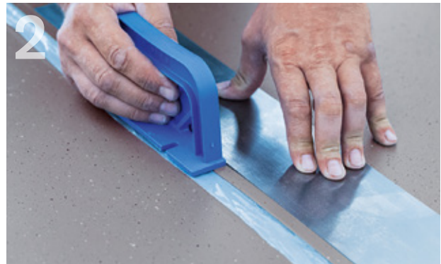
Belag auslegen und durch Zuschnitt individuell anpassen.
