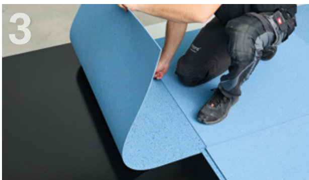
nora® ed/ec Bodenbelag verlegen.
